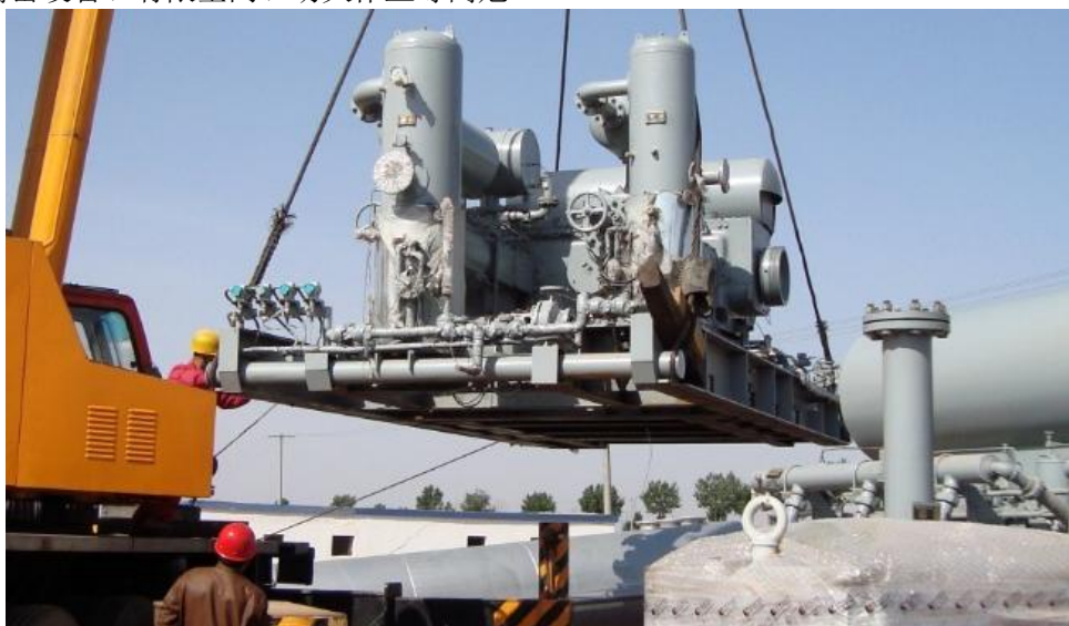
图1 基建收尾阶段设备吊装
